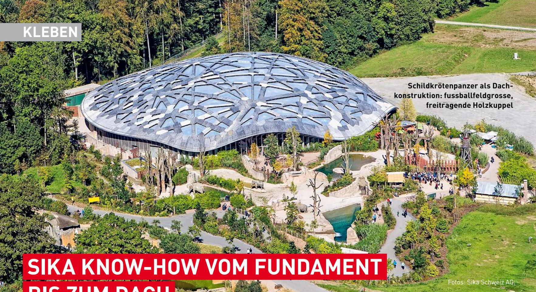
Schildkrötenpanzer als Dachkonstruktion: fussballfeldgrosse, freitragende Holzkuppel
