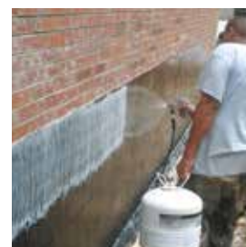
Pour une installation rapide et facile des panneaux d'isolant, pulvérisez et collez simplement avec la colle en bonbonne 3M™ HoldFast 70. Colle la mousse au béton, à la bande d'étanchéité, à de l'OSB et plus sans endommager la mousse.
